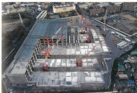
FSRPC-B建て逃げ工法施工状況(敷地南側より)
