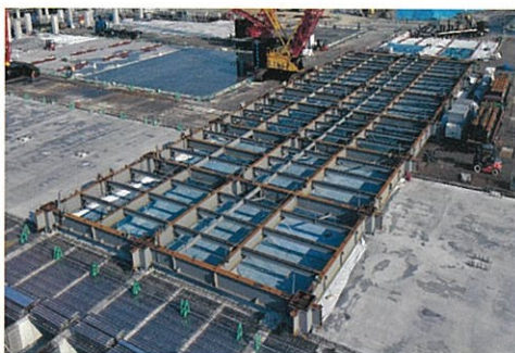
地上面での大規模仮組状況
