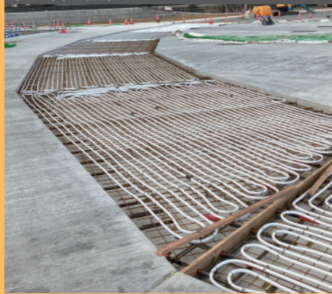
放熱管敷設状況
