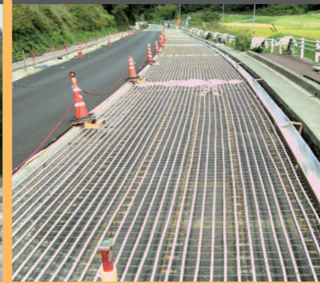
放熱管敷設状況
